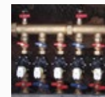
Schacht mit Hauptzuleitung und Magnetventilen
