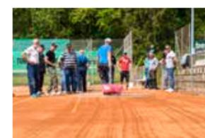
Randbereich nach Regen und Nachtbewässerung durch ziehen mit dem Stahldrahtbesen auflockern. Dabei kann der Besen mit einem Sandsack beschwert werden um mehr Druck zu erzeugen. Stahldrahtbesen finden Sie auf der **Seite 16**.
