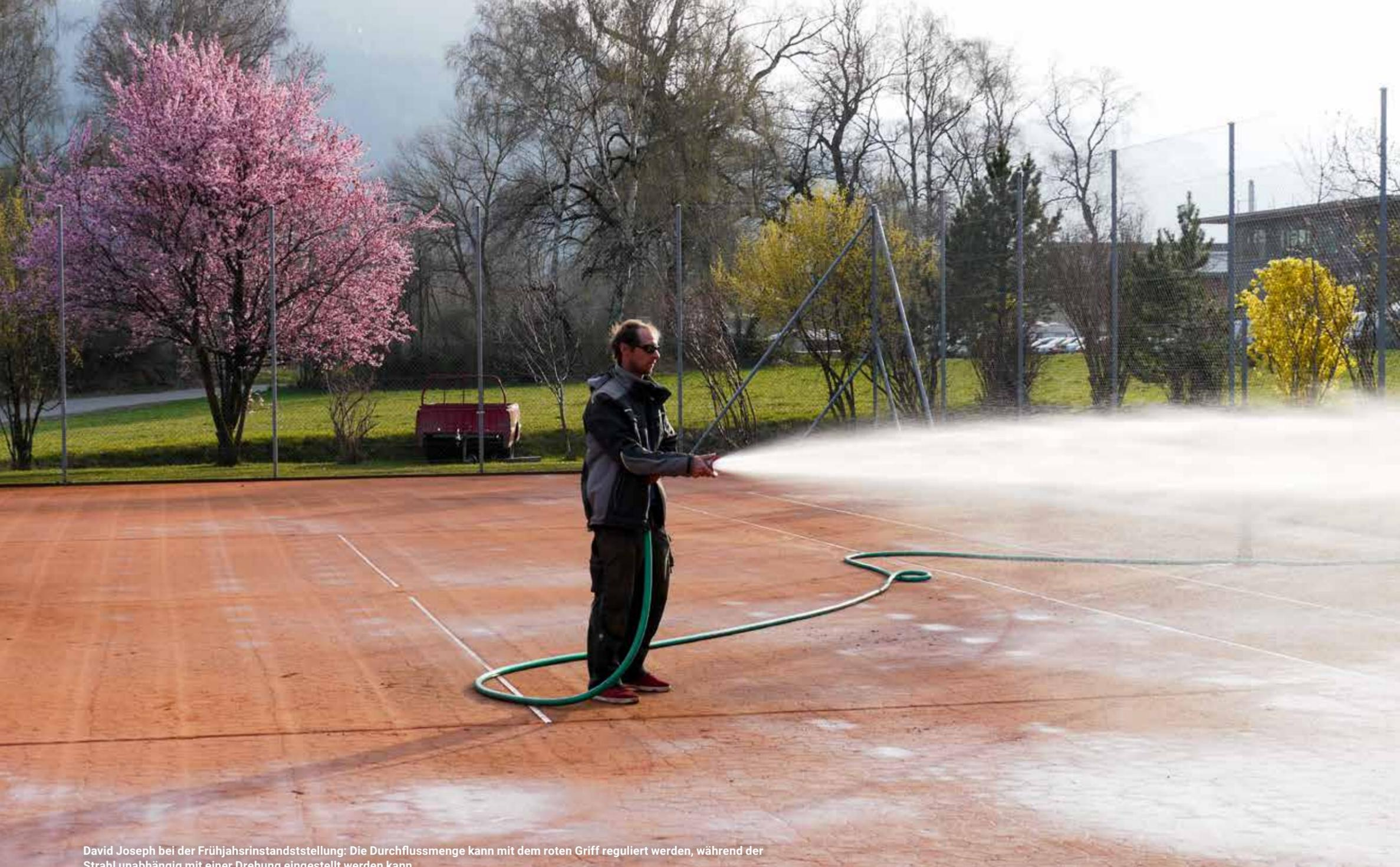
David Joseph bei der Frühjahrsinstandstellung: Die Durchflussmenge kann mit dem roten Griff reguliert werden, während der Strahl unabhängig mit einer Drehung eingestellt werden kann.
