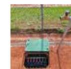
Schacht mit Hauptzuleitung und Magnetventilen
