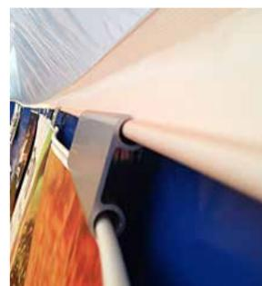
PVC Blenden mit Keder haben in der Traglufthalle normalerweise die Masse 2.65 x 1.30 m.
